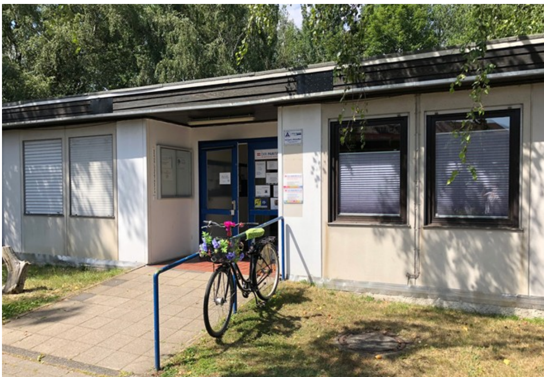
Abbildung 1: Das Gebäude an der Dortmunder Str. 13 in Witten.
